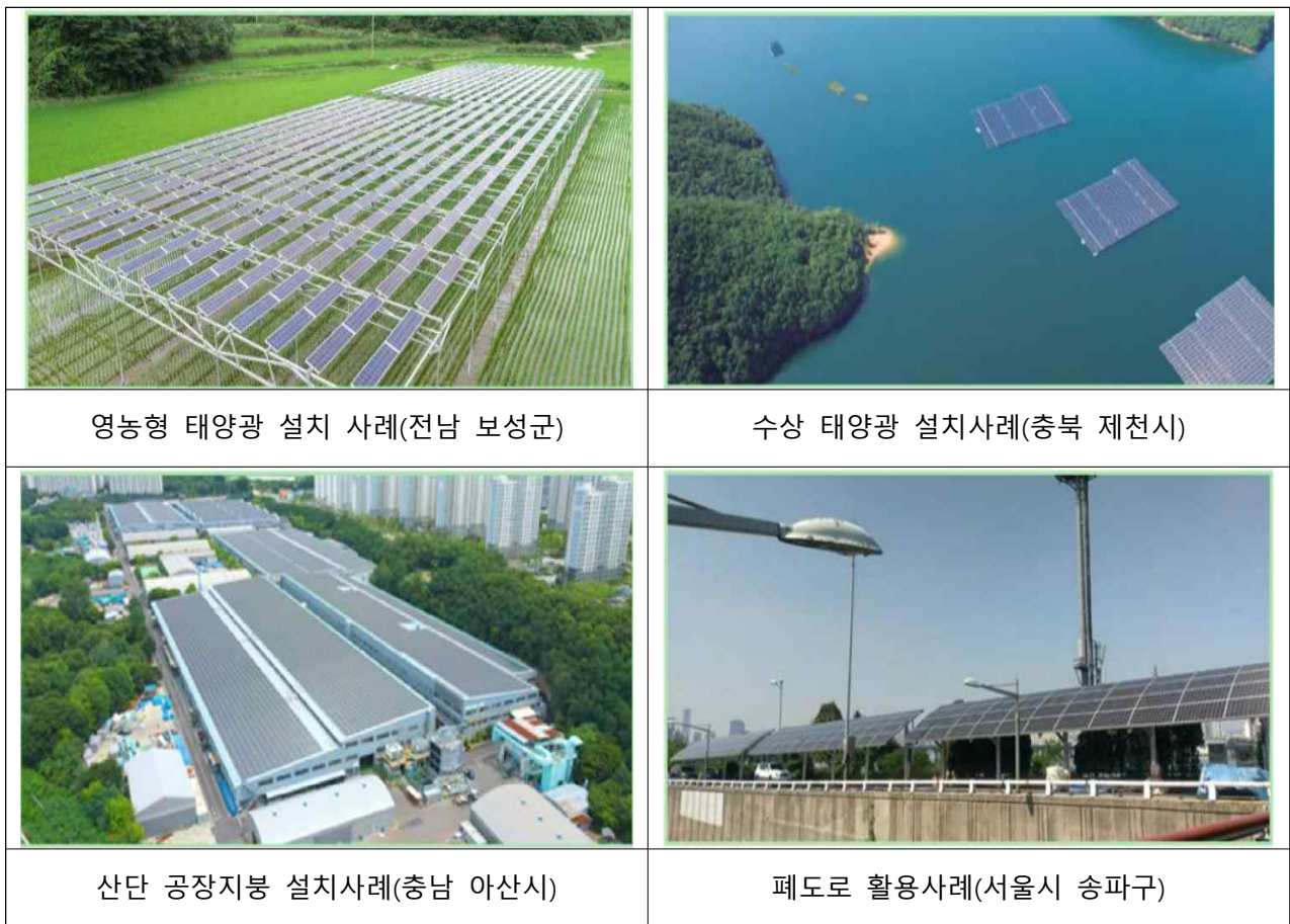
[그림 3-25] 유휴부지를 활용한 태양광 설치 사례
