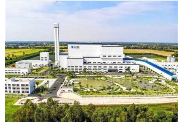
컨터시 타이라이(Thoi Lai)군 waste-to-energy plant(사진: moit.gov.vn)
