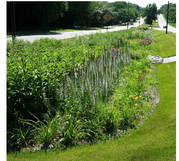
Rigoles de drainage biologique
