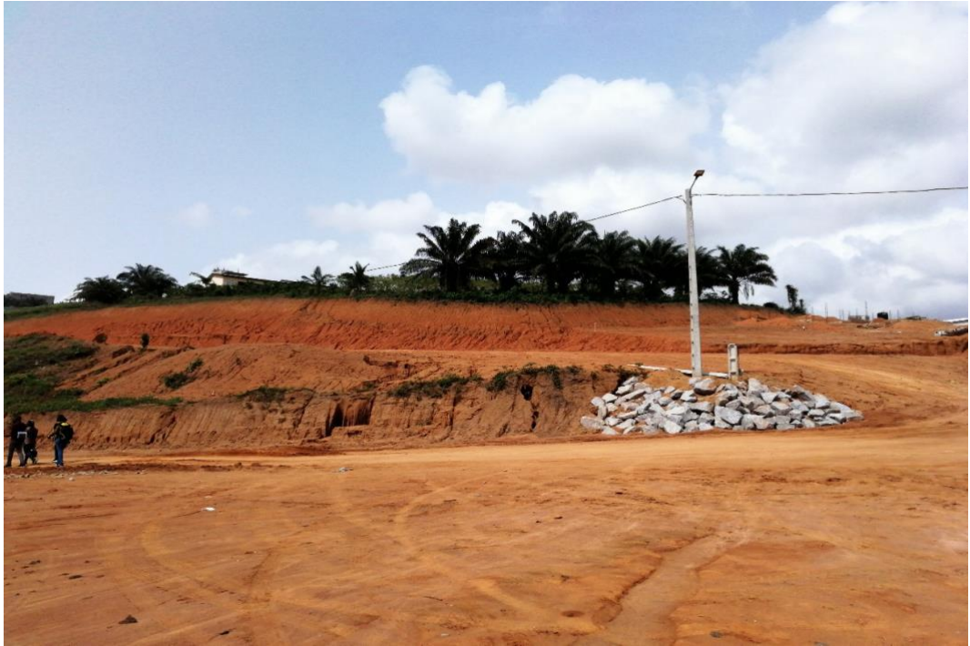
Fig. 24 - OUVERTURE D'UNE VOIE BITUMEE DANS LE VILLAGE DE KOFFAKOI.
