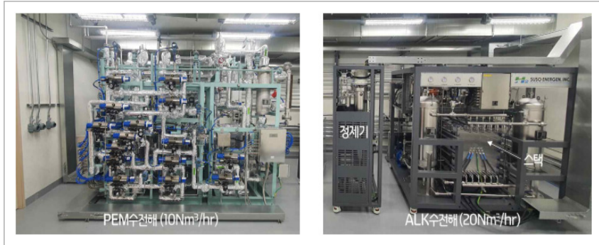
그림 7 그린수소 실증 단지 PEM(좌) 및 ALK(우) 수전해 설비
