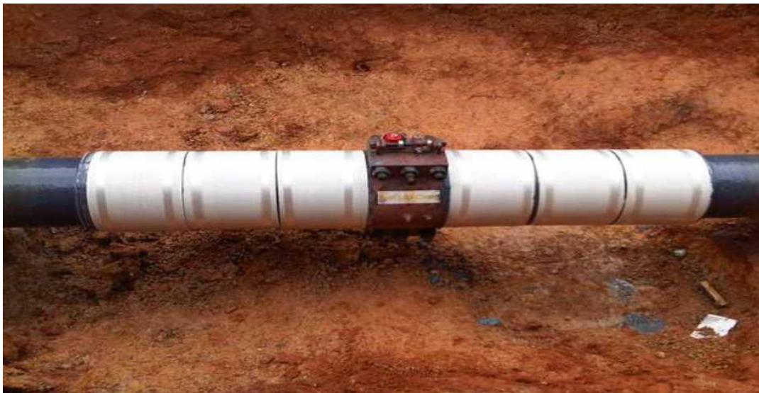
〈그림 30〉 균열 방지기를 이용한 배관 보수 [56]
