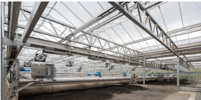
• 이미지 출처 : 마이클 샘밀러(Michael Sammler) 링크드인(Linked-in)( www.linkedin.com ), "HUBER Supplies the Biggest Solar Sludge Drying Facility Worldwide!", 2019-12-06)
