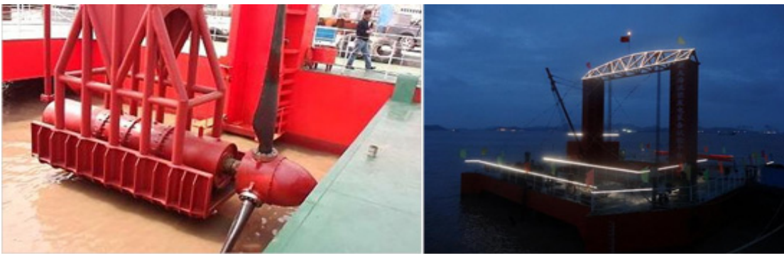
〈그림 3〉 60kW급 수평축 조류 발전 장치 실증시험 및 야경
